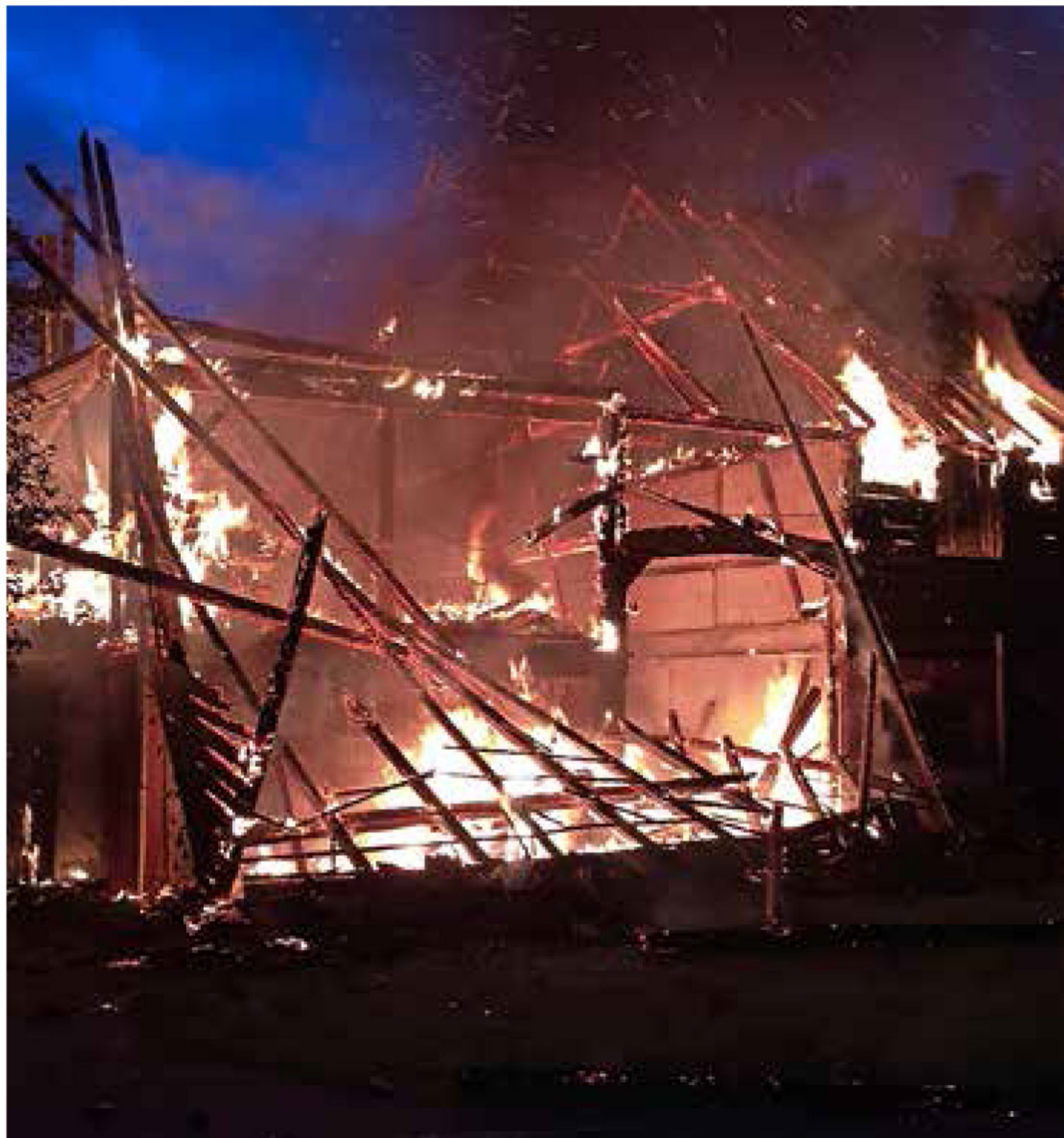
Der Schopf wurde vom Feuer vollständig zerstört.
